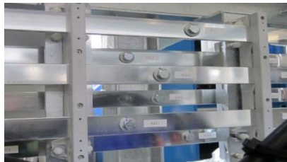
메인 설비 내부에 적용한 부스바 확대 사진
